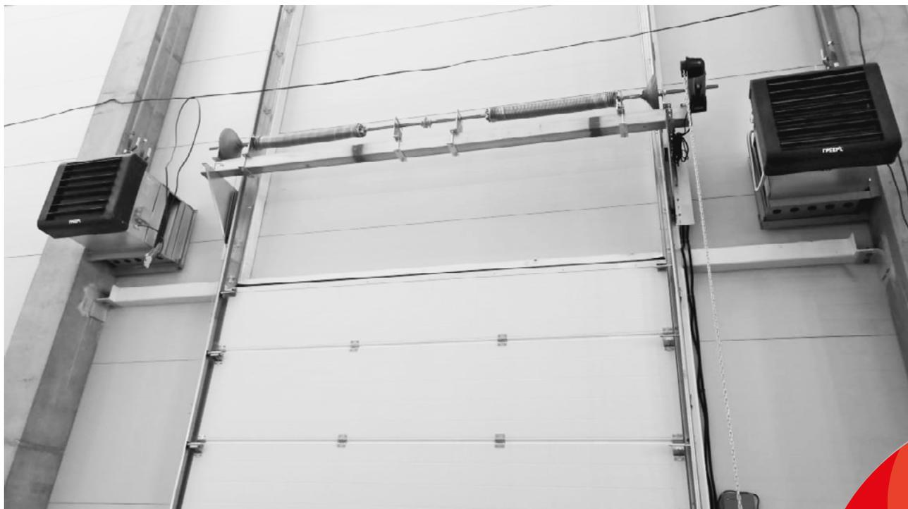
**?** **Задача:** предотвращение притока холодного уличного воздуха в производственном цехе, снижение теплотерь и затрат на отопление.
