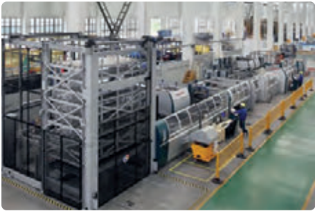
Склад лифтового оборудования «Регионлифт» г. Новосибирск
