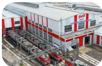
Ремонтное депо РЖД, г. Чита
