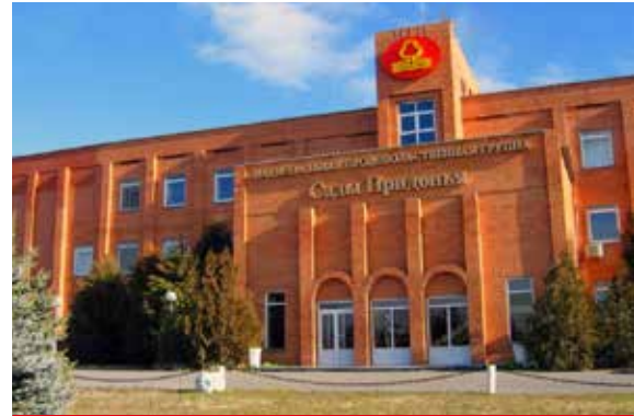
Цех Сады Придонья г. Волгоград
