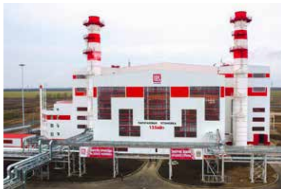
Котельная Запикетная г. Кисловодск
